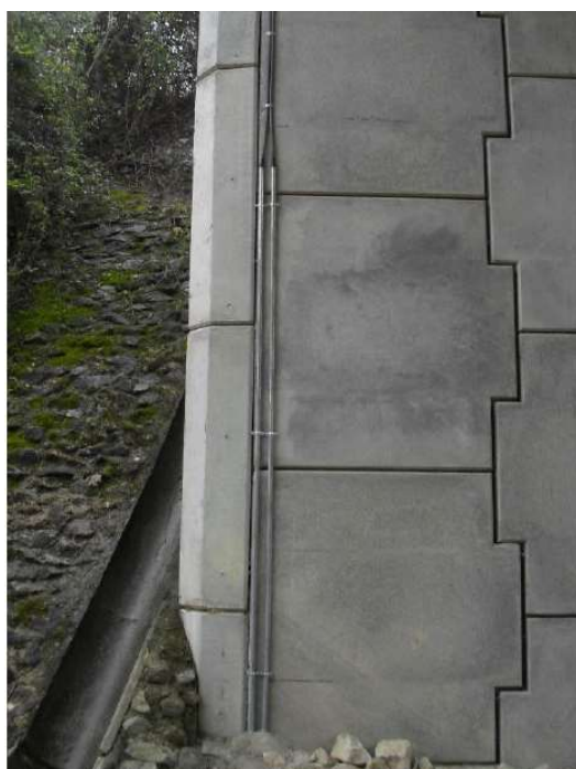
Figura 28 – Tubo ferro galvanizado para proteção de cabos.
