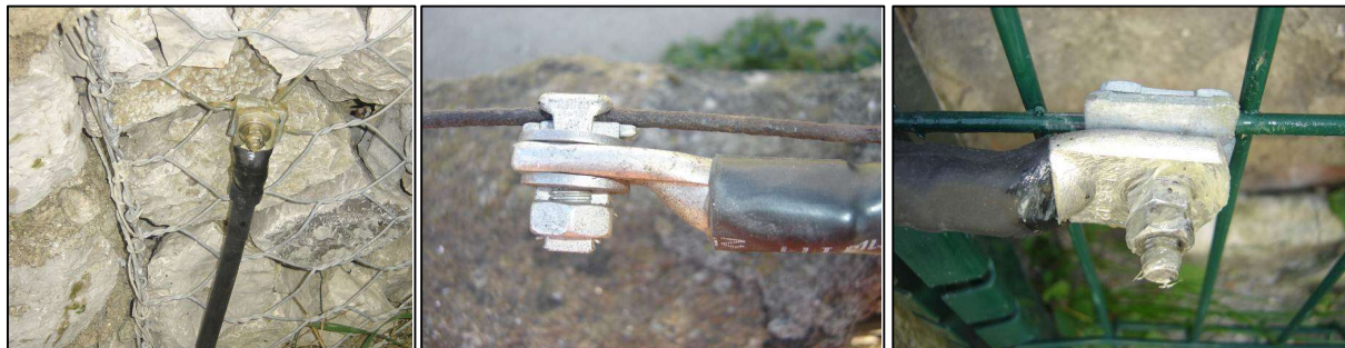
Figura 21 – Ligadores para conexão de redes metálicas.
