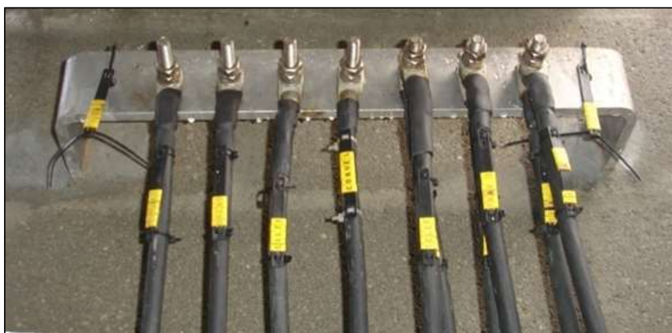
Figura 7 – Exemplo de ligação à Barra de Terra
